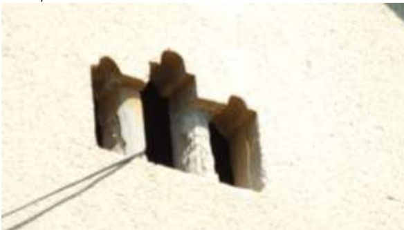
Padlásnyílás az oromfalban
